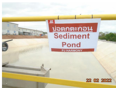
ภาพที่ 2-13 รางระบายน้ำและบ่อดักตะกอน
