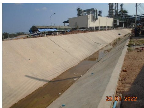
ภาพที่ 2-13 รางระบายน้ำและบ่อดักตะกอน
