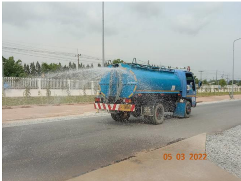
ภาพที่ 2-1 การฉีดพรมน้ำในพื้นที่ก่อสร้าง
